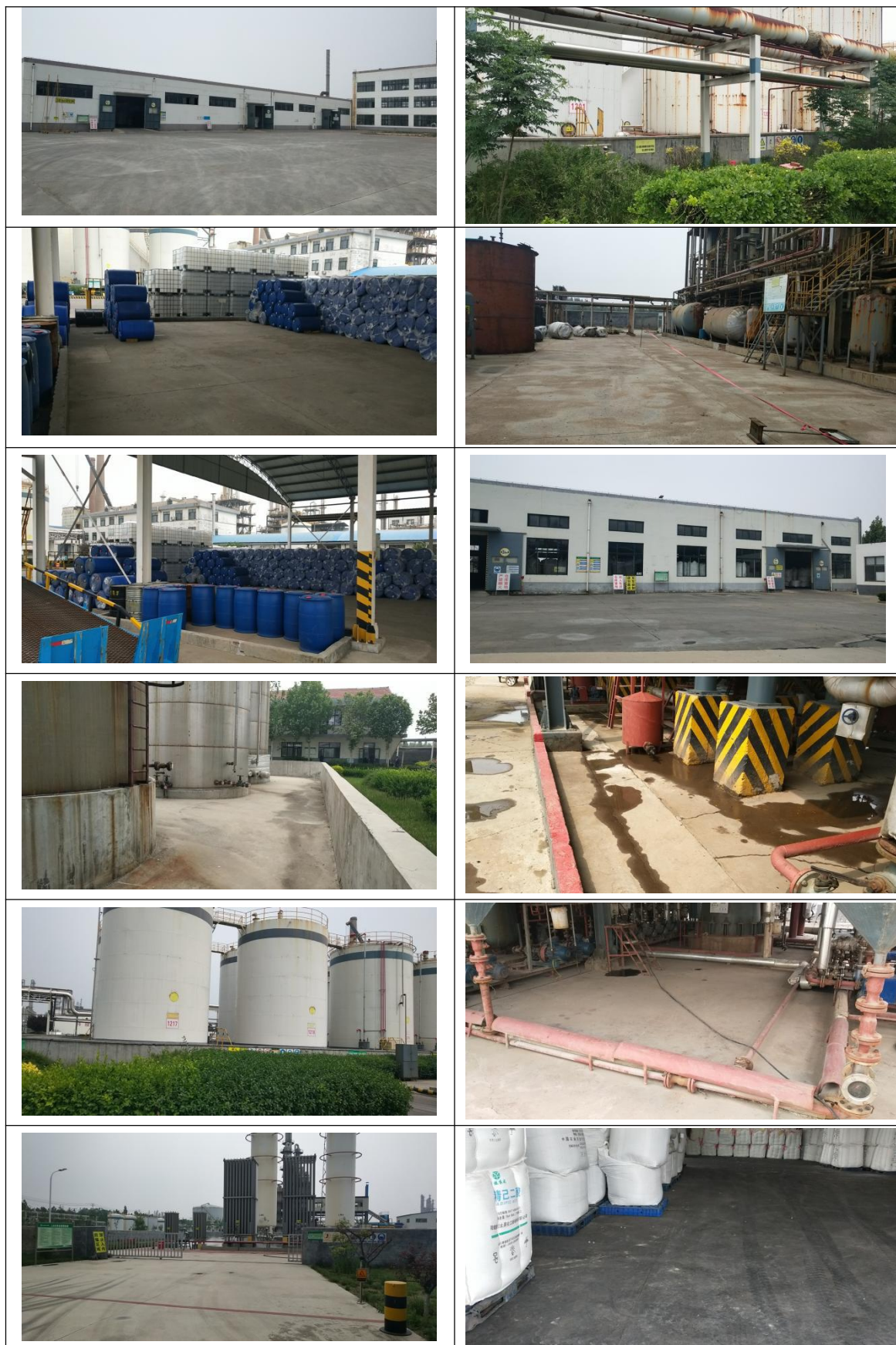
图 4.2-1 排查现场照片
